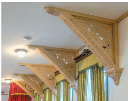
音響にも配慮された、梁を支える持送り
