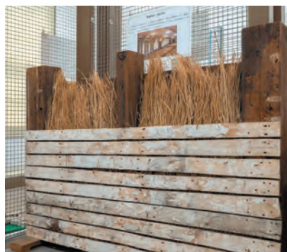
壁の中には遮音材として藁やおがくずが詰められている
