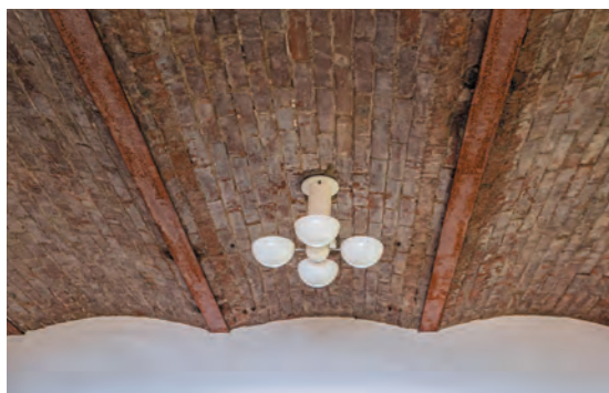
レンガづくりのアーチ構造部。建設当時のまま残されている
